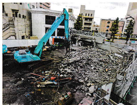
旧納骨堂解体中の中の状態
