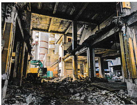
本堂解体中の中の状態
