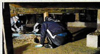
泥を排出作業
